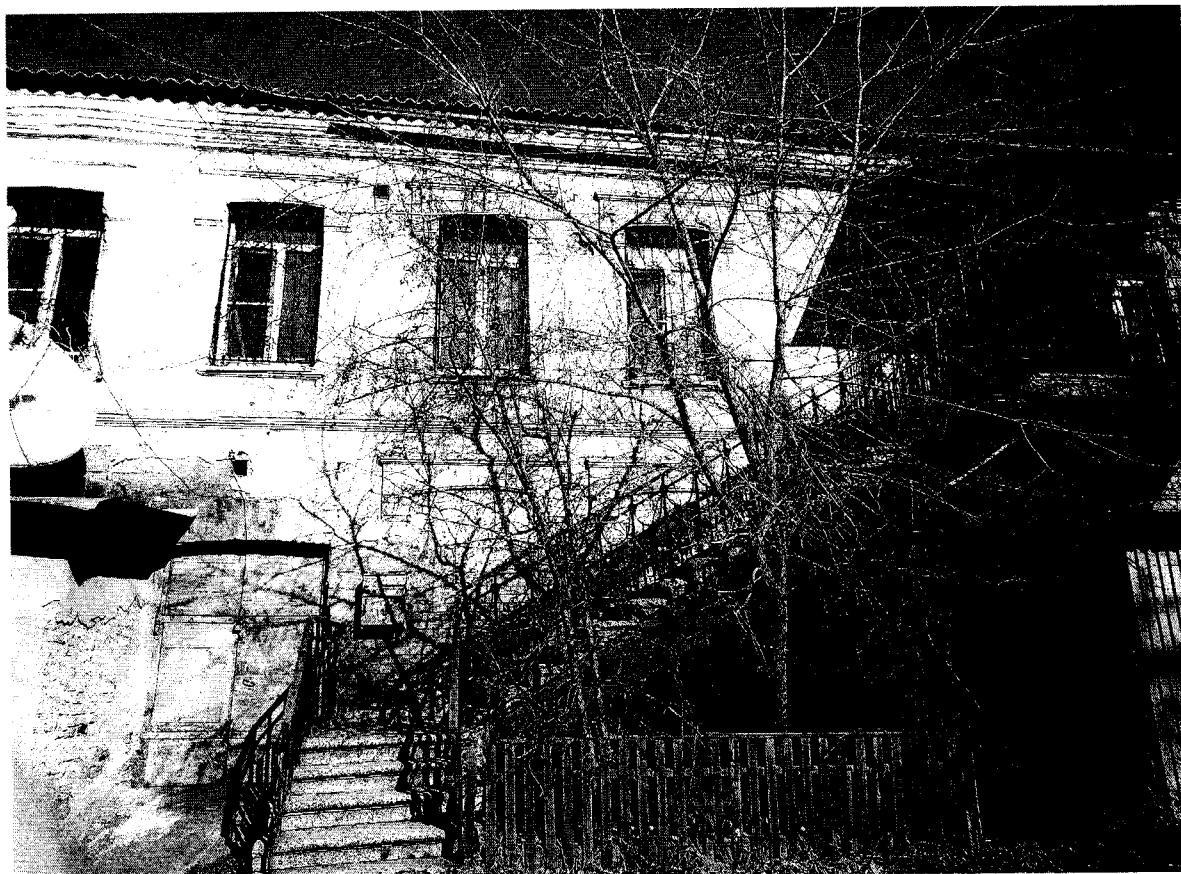
Фото 5 Крыльцо. Фрагмент юго--западного фасада. ул. Амурская, 104а
