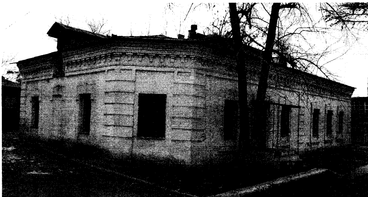
Фото 3. Вид с севера на северо-западный и северо-восточный дворовые фасады.
